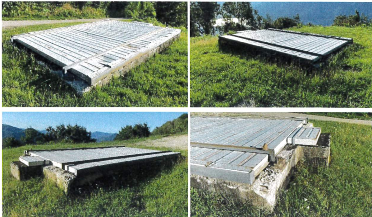
Figura 4: Stato attuale della vasca antincendio da più prospettive.
