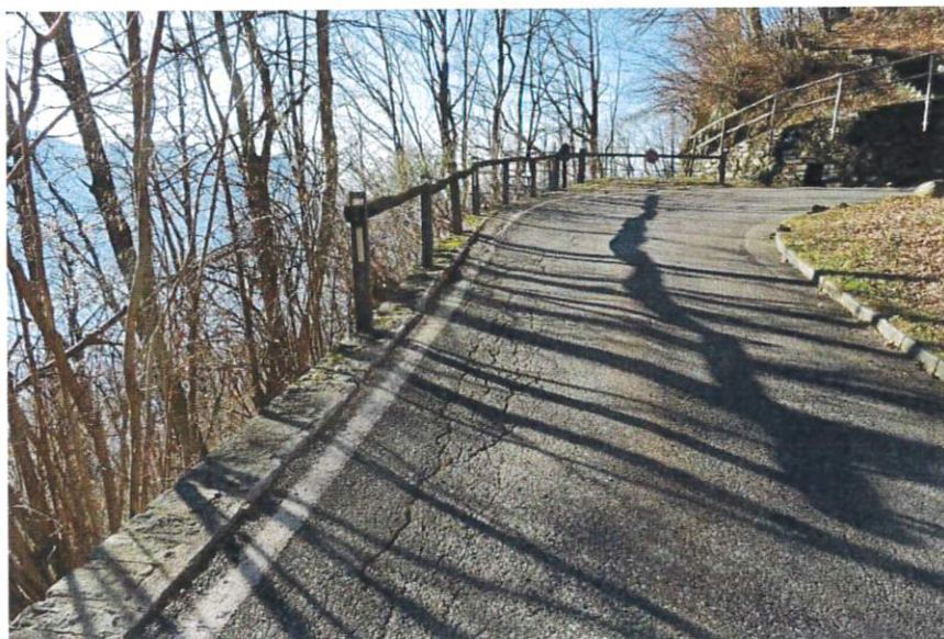
Figura 22. Tornante 1: cedimento dell'asfalto vista da valle
