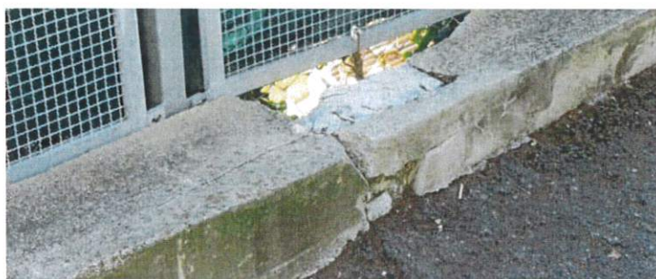
Figura 30. Danneggiamento superficiale cordolo spalla di monte lato lago
