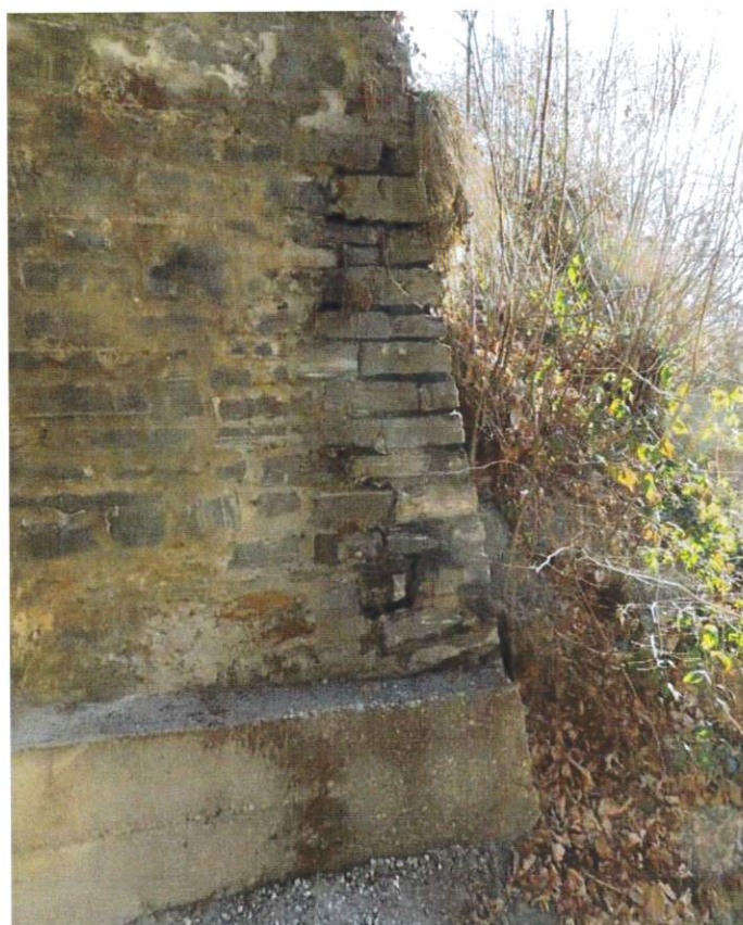
Figura 16. Ponte 2: dettaglio difetto spalla di monte lato lago
