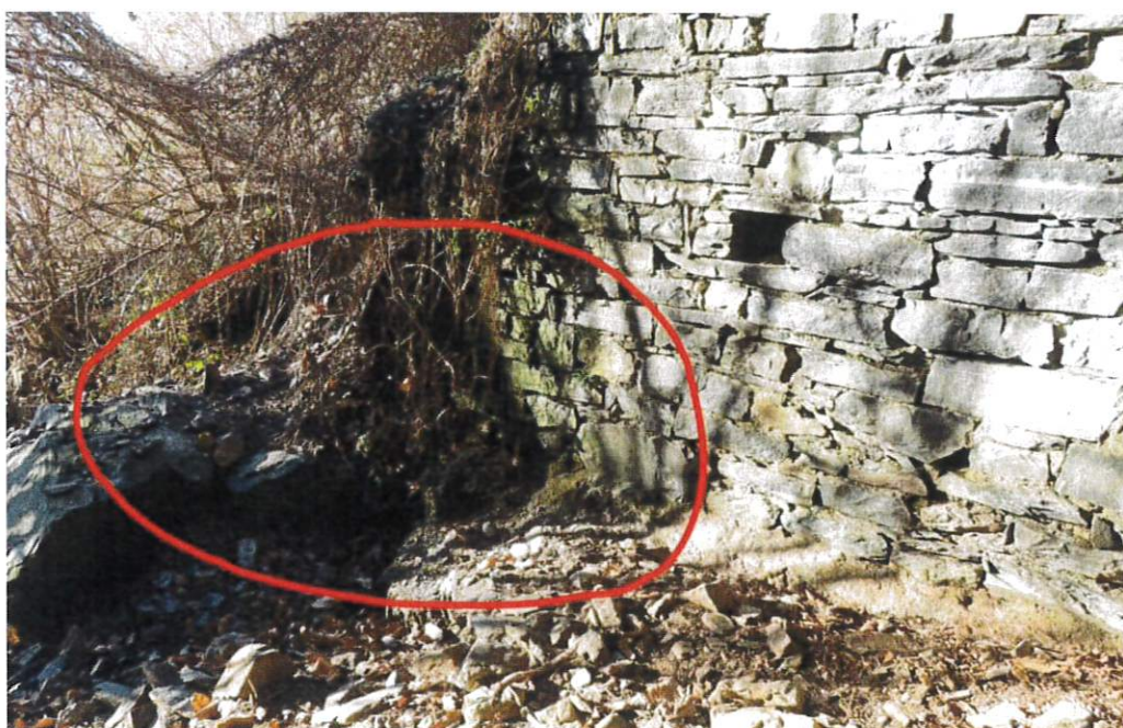
Figura 8. Spalla di monte lato lago. Evidenziato il dilavamento del piano di appoggio fondazioni
