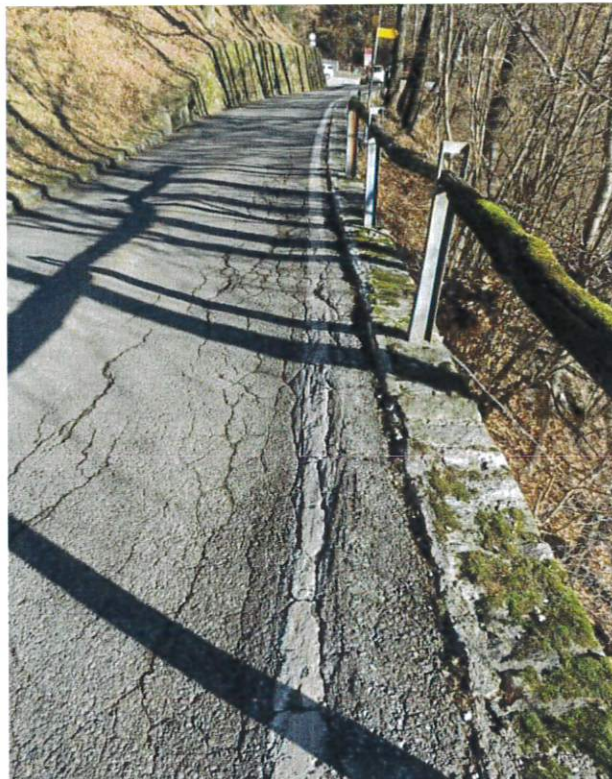
Figura 21. Tornante 1: cedimento dell'asfalto visto da monte
