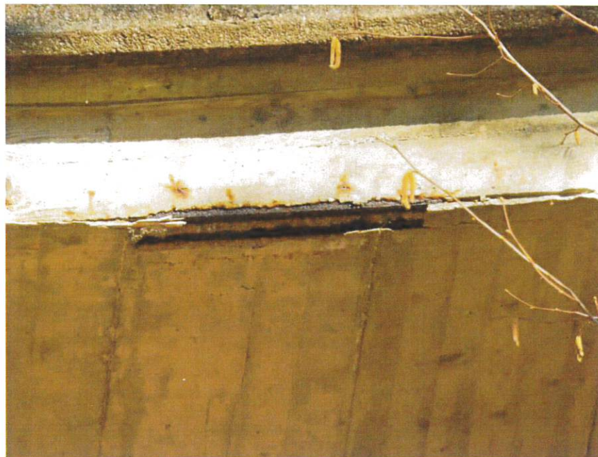
Figura 13. Ponte 2: espulsione del copriferro e danneggiamento delle armature
