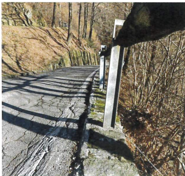
Figura 23. Tornante 1: dettaglio rotazione del cordolo
