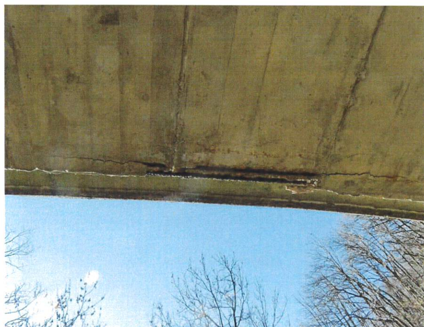
Figura 14. Ponte 2: danno al copriferro, vista da monte
