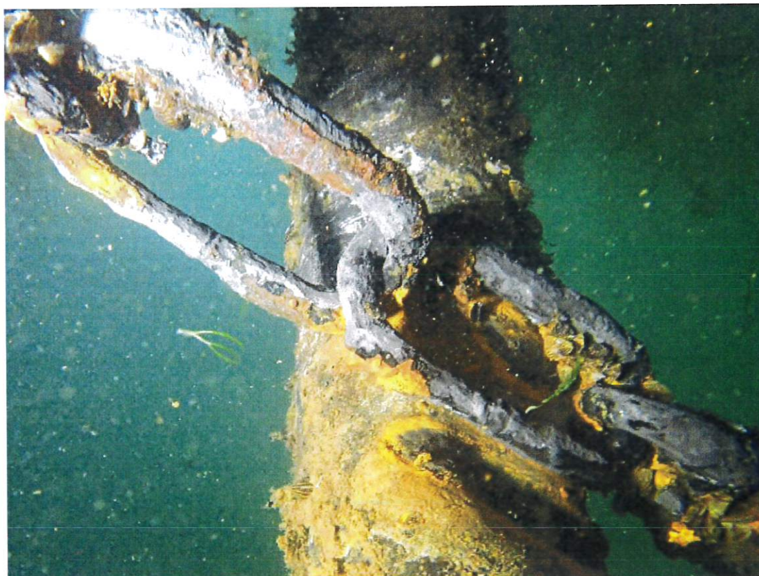
Croce della catena K3/K5: catena usurata e tubo di protezione
