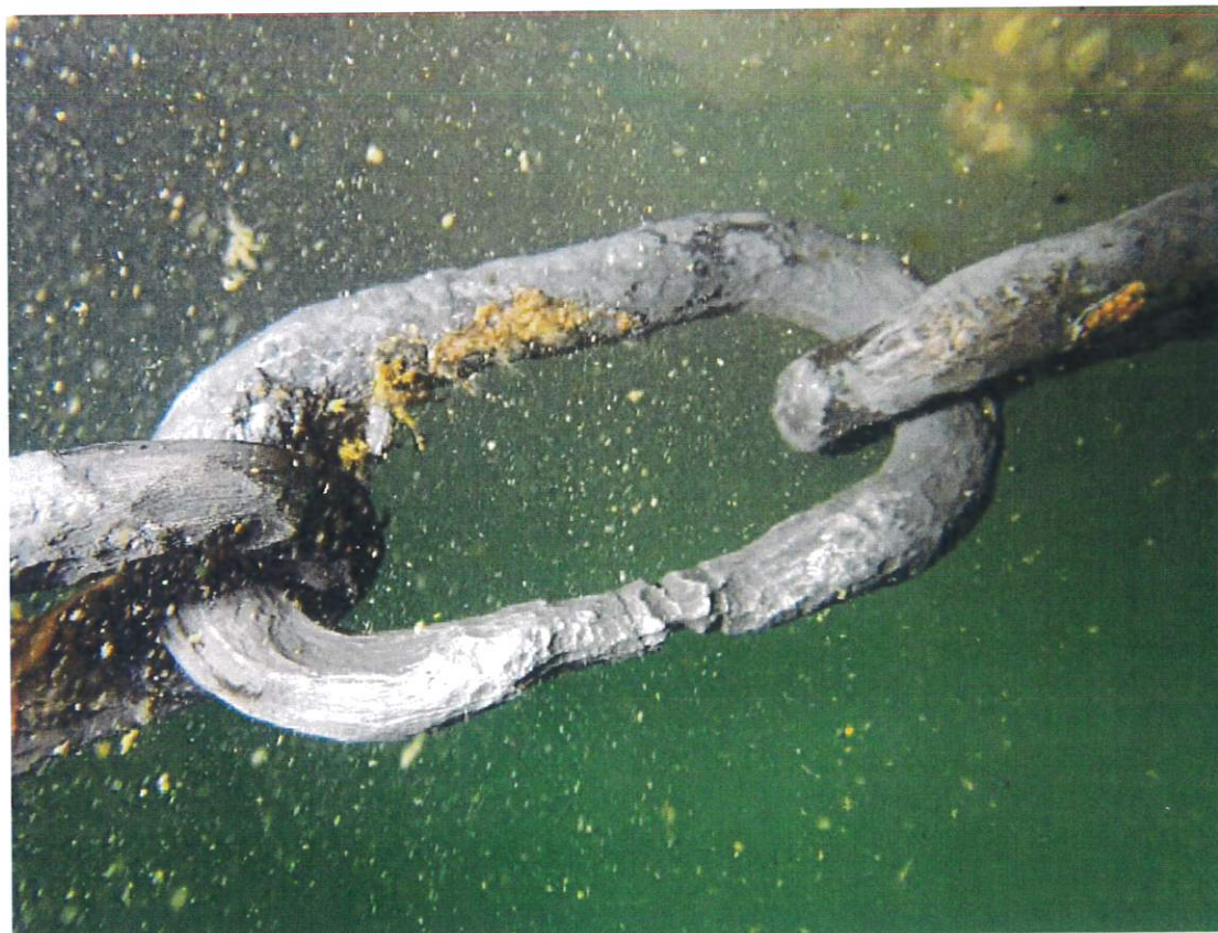
Catena K7: collegamento al molo, catena usurata
