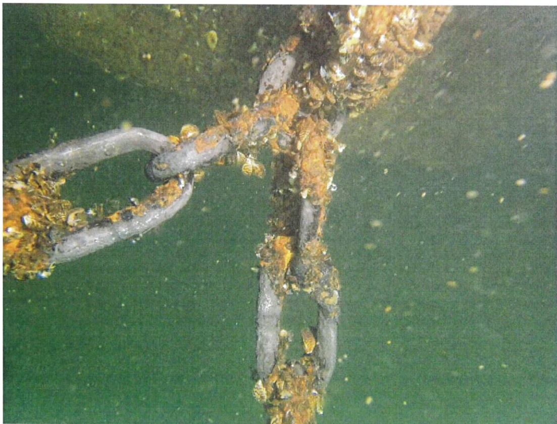
Catena K6: collegamento alla piastra ad occhio del contrappeso K4/K5
