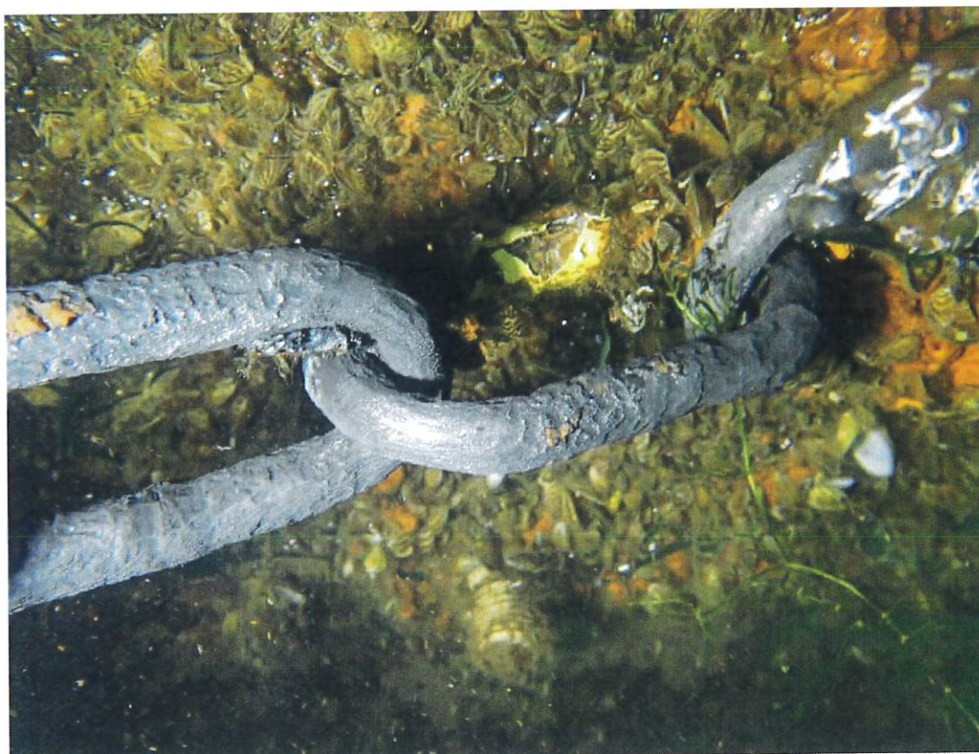
Catena K1: collegamento al molo
