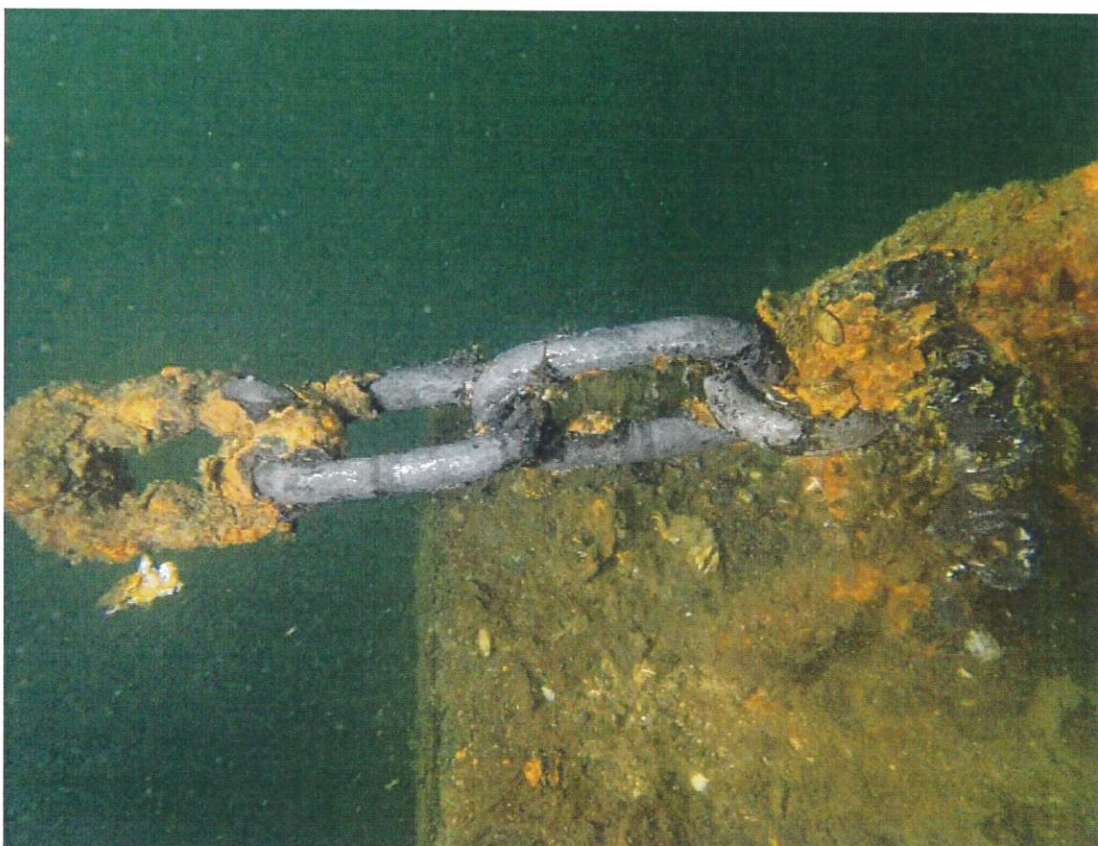
Catena K1: collegamento alla piastra ad occhio Pietra di zavorra K2/K3
